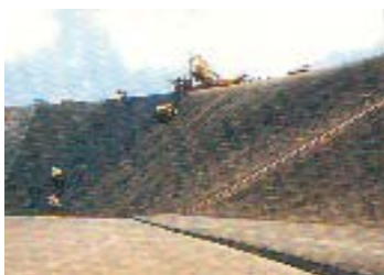
งานก่อสร้างอ่างพักน้ำตอนบน
